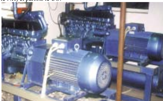
Module de co-génération avec générateur asynchrone et échangeur de chaleur sur les gaz d'échappement
